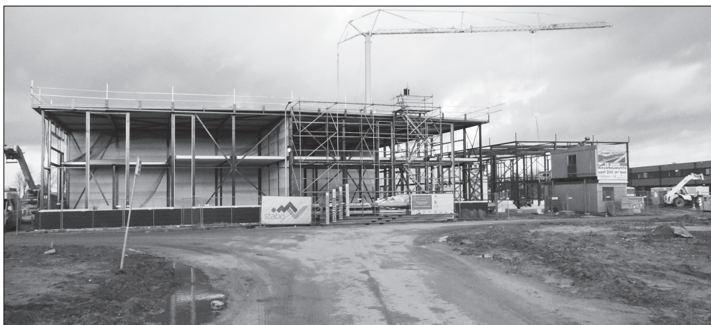
Nieuwbouw op bedrijventerrein Zevenhuis (foto Jan Smit).
